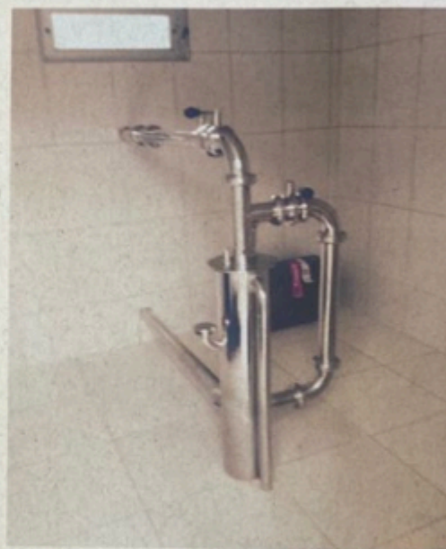
Foto 02 - Vista da Cabeça do Poço
