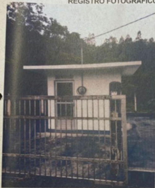
Foto 01 - Vista Externa da Casa de Proteção
