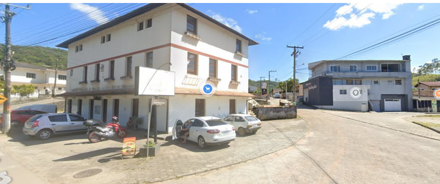
Edificação em Santa Teresa com uso misto
